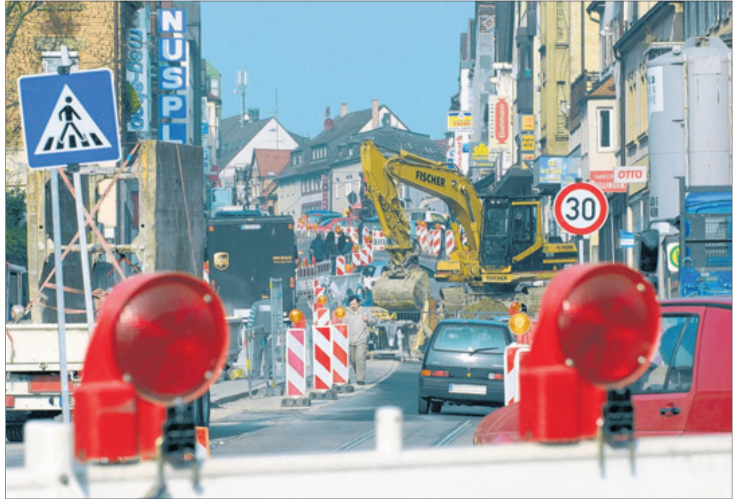
Schilderwald im Stadtbezirk: Noch mindestens bis August 2010 wird entlang Unterländer Straße in Zuffenhausen gebaut.
